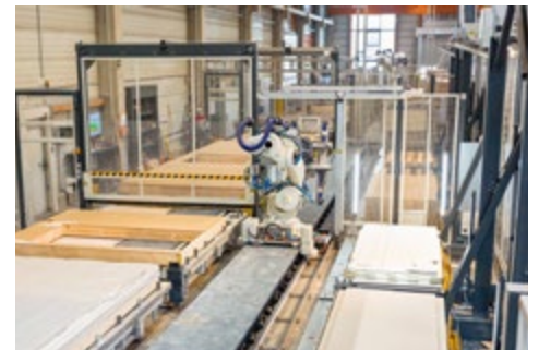
Zellenwechsel zu Gipsbauplattenzelle
